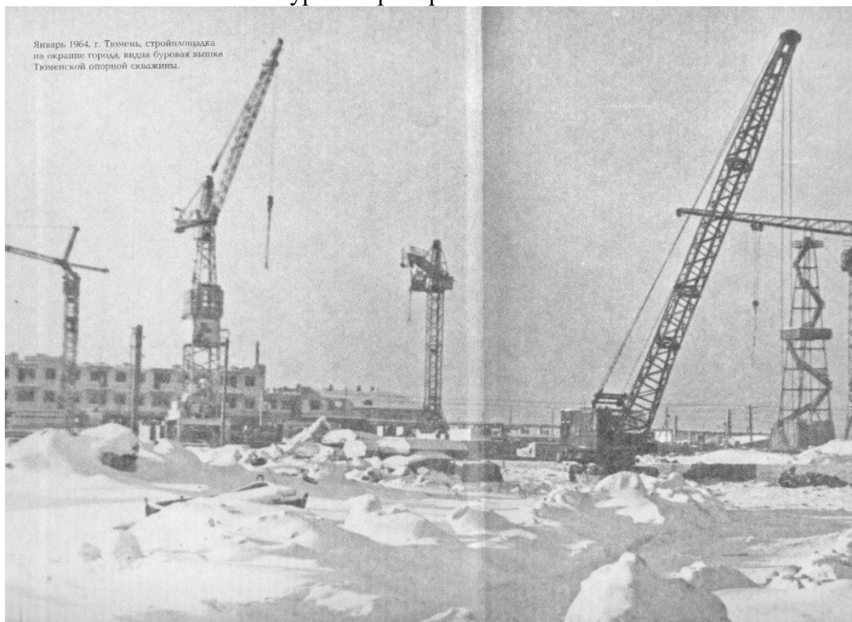
Рис. 3 - Строительство домов на окраине города (Тюмень, январь 1964 г.). Справа на фото видна буровая вышка Тюменской опорной скважины № 1-Р.
